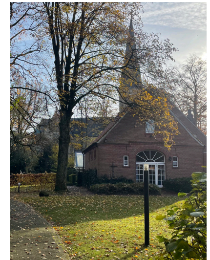
Abb. 41 | ehemaliges Pastorat von Norden
