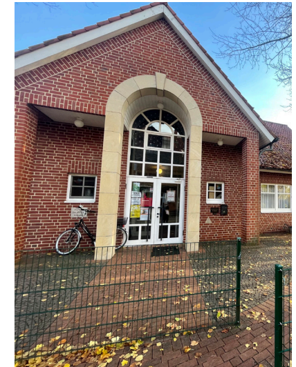
Abb. 12 | Pfarrheim „Die Brücke“
