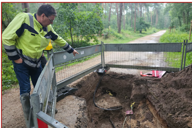
Tiefbauarbeiten im Offlumer Wald für die Rohre und Leitungen zwischen dem neuen Brunnen und dem Wasserwerk.
